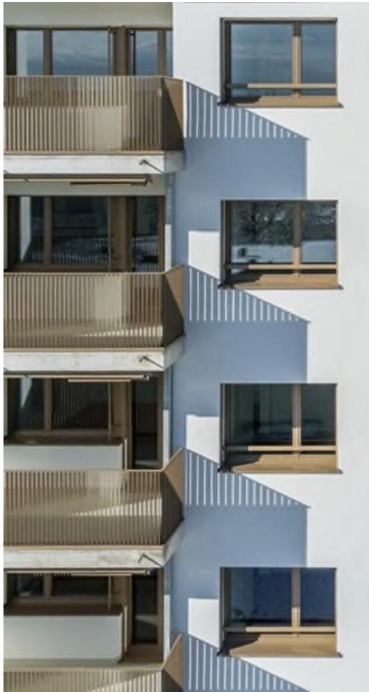
Glattbrugg, Talackerstrasse 53b
