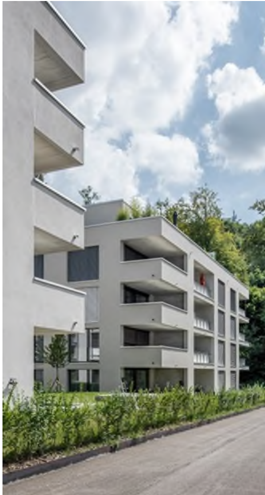
Zofingen, Riedtalstrasse 18a/18b/20a
