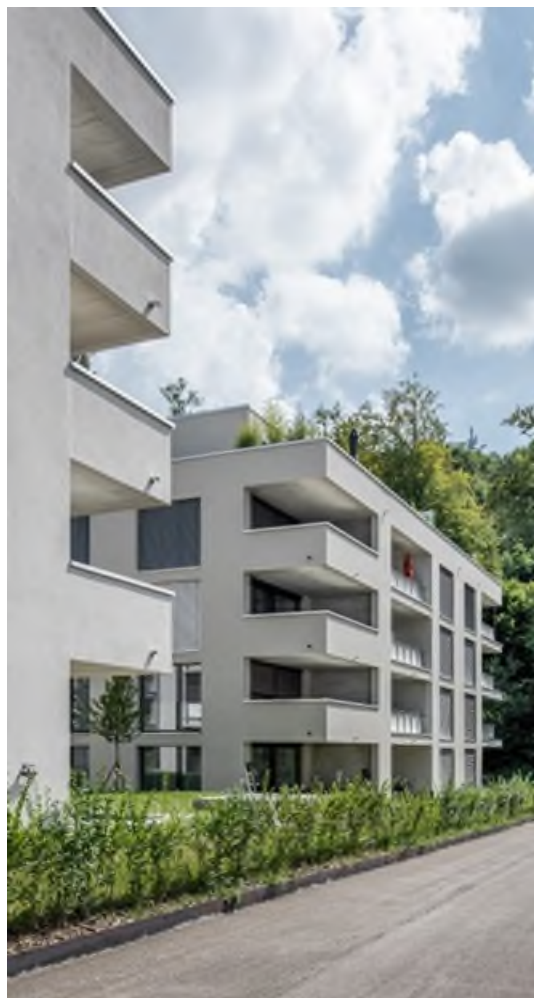
Zofingen, Riedtalstrasse 18a/18b/20a
