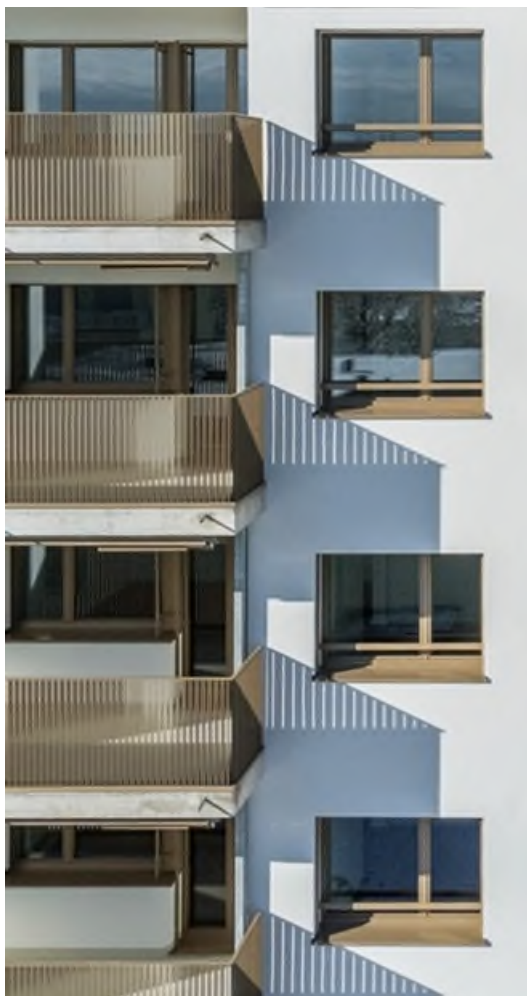
Glattbrugg, Talackerstrasse 53b
