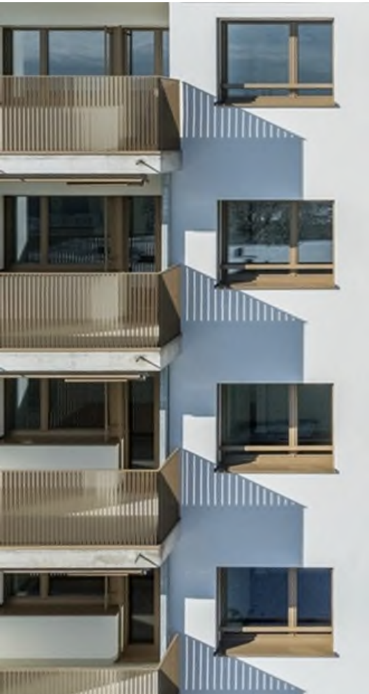
Glattbrugg, Talackerstrasse 53b
