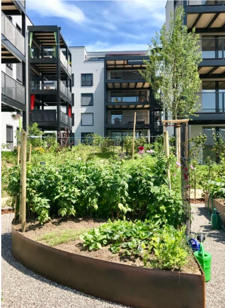
Hirwi, Zürichstrasse 60a/60b1
