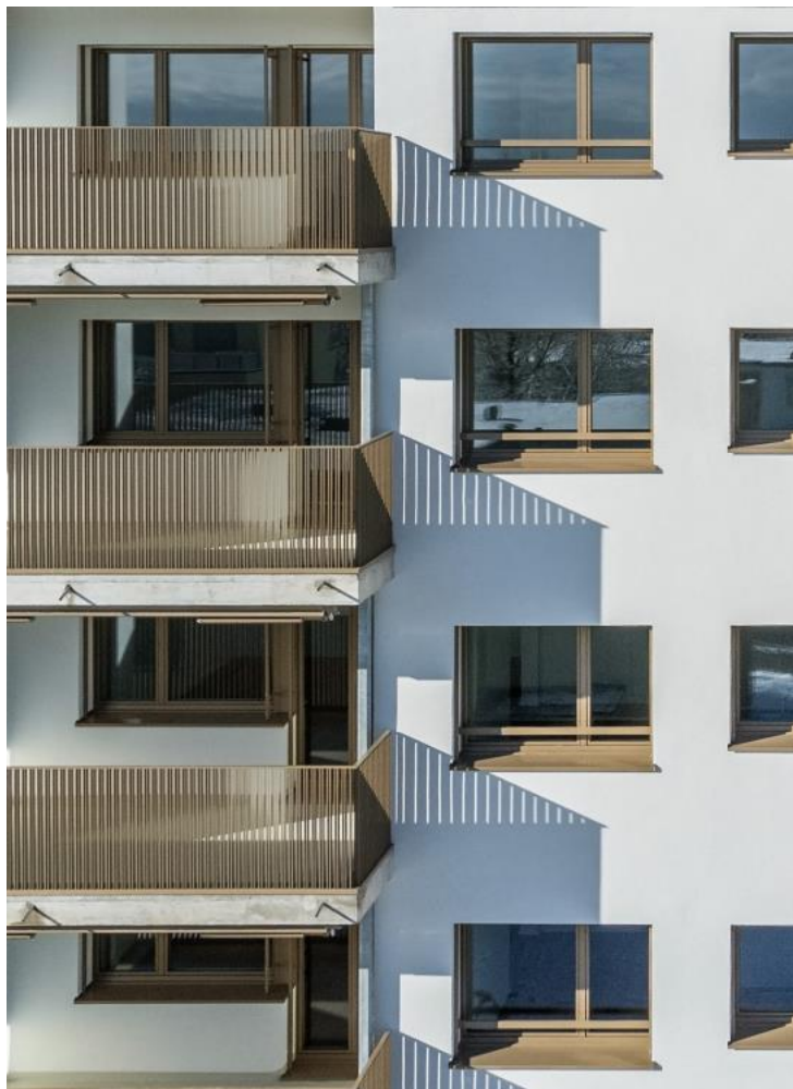
Glattbrugg, Talackerstrasse 53b
