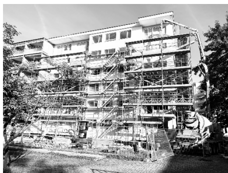
^ ...des travaux sont en cours sur le côté droit pour les nouveaux balcons
